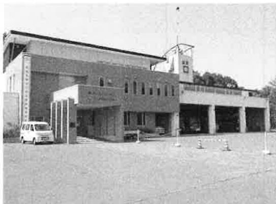
川湯消防庁舎
