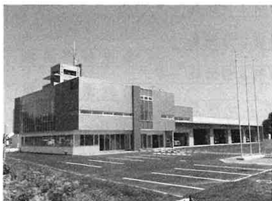
弟子屈消防庁舎
