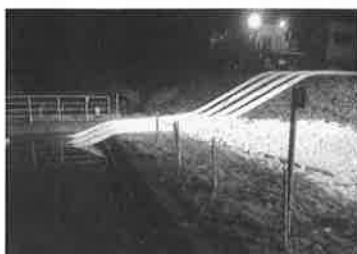
【標茶町】 内水氾濫による釧路川増水時 排水の様子
