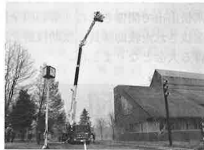
はしご車による高所放水の様子
