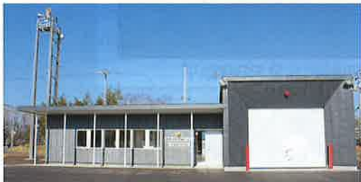
下幌呂消防部新詰所
