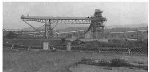
かさ上げ工事用ベルトコンベア
