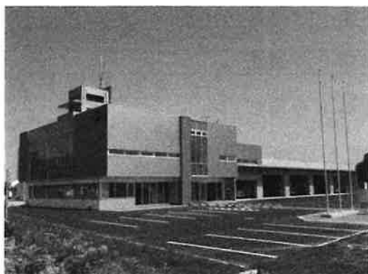
弟子屈消防庁舎
