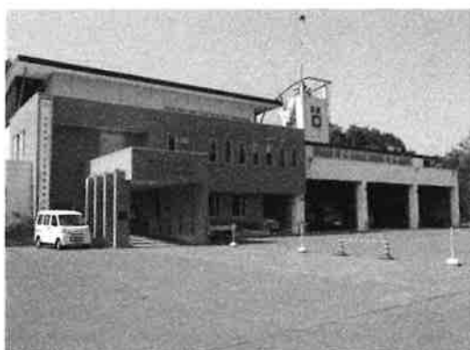
川湯消防庁舎
