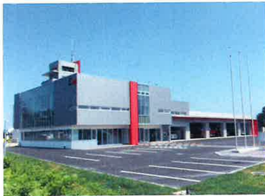
弟子屈消防庁舎
