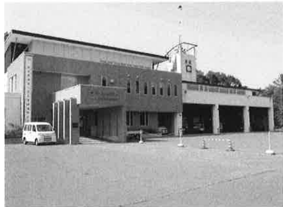
川湯消防庁舎
