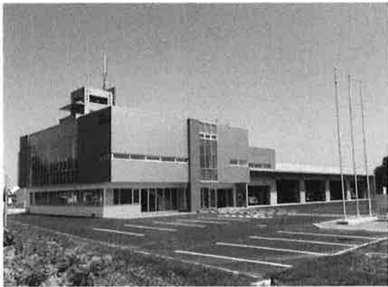
弟子屈消防庁舎
