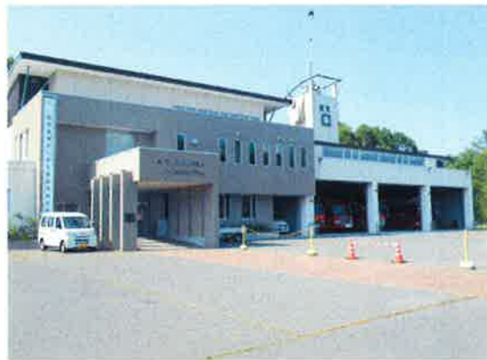
川湯消防庁舎
