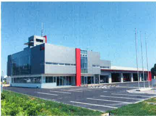
弟子屈消防庁舎
