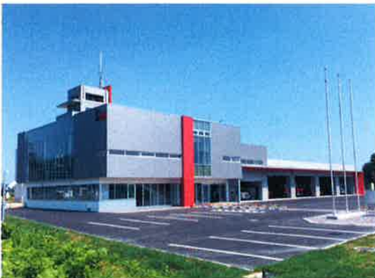
弟子屈消防庁舎
