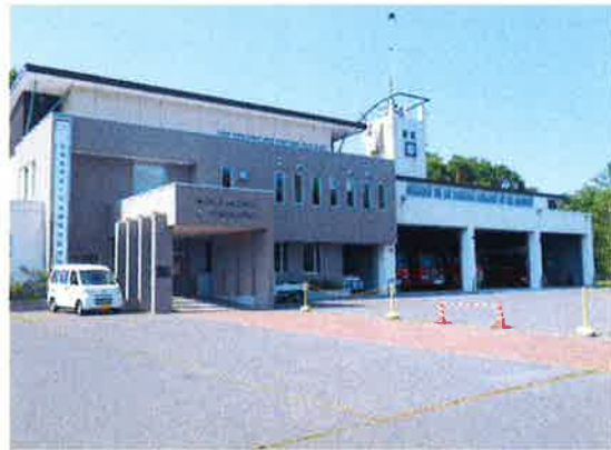
川湯消防庁舎
