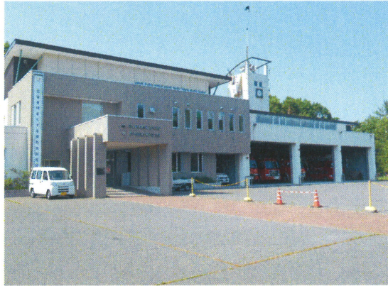
川湯消防庁舎
