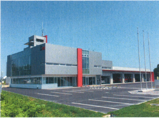
弟子屈消防庁舎
