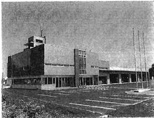
弟子屈消防庁舎
