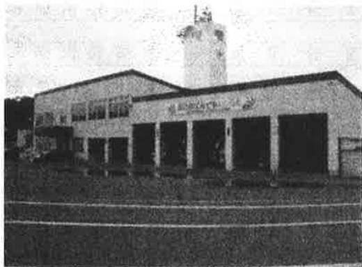
弟子屈消防庁舎
